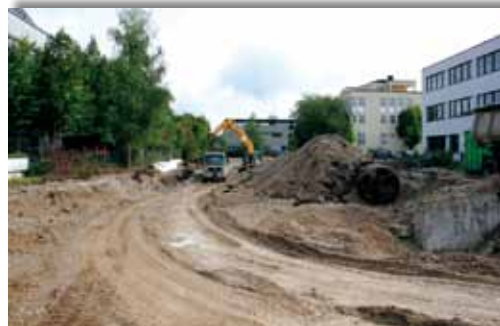
● Baustelle aktuell Mitte September
